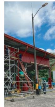
▲ Instalación de canales y bajantes en caseta auxiliar SPCI
