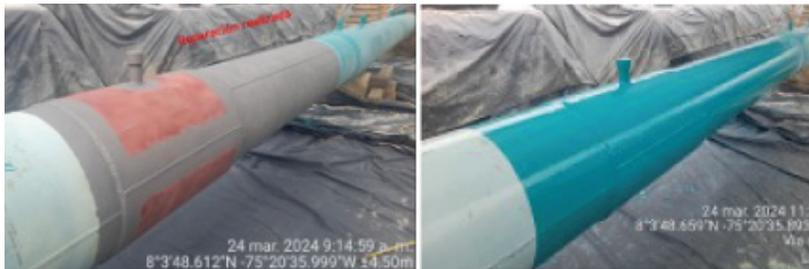
Durante el primer semestre de 2024, avanza con la ejecución de obras para la gestión del riesgo de corrosión, cumpliendo con el 60% del plan anual de integridad (PAI) en su componente de reparaciones mecánicas. Este avance incluyó la ejecución de reparaciones en los puntos identificados en la gráfica.
