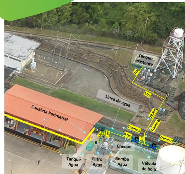
Ilustración 1 Sistema de recolección de aguas lluvias
