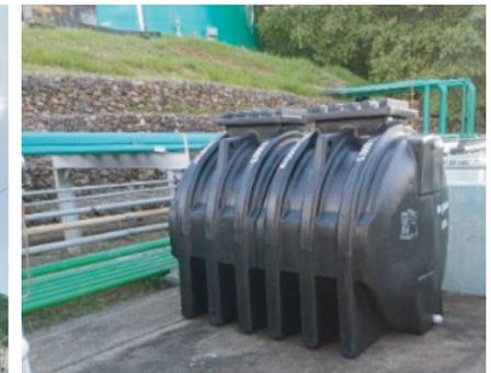
▲ Instalación de tanque de almacenamiento de agua en caseta auxiliar SPCI
